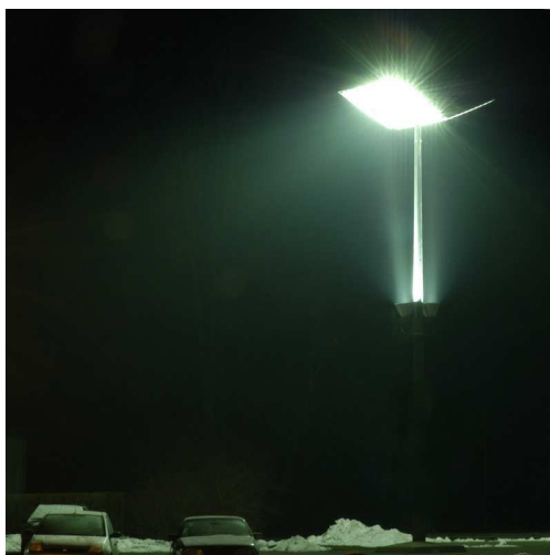
Obr. 3.31 - systém přesného směřování prostřednictvím sekundárních zrcadel
